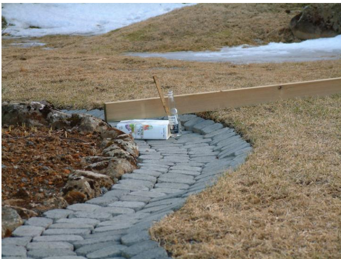
Mynd 6. Frostlyfting. Að sumri er grasbalinn jafnhár stéttinni. Undir stéttinni er frostfrítt efni (möl og sandur). Í frostum myndast holklaki undir grasinu og grasflötin lyftist, en stutt er niður á grunnvatn.
